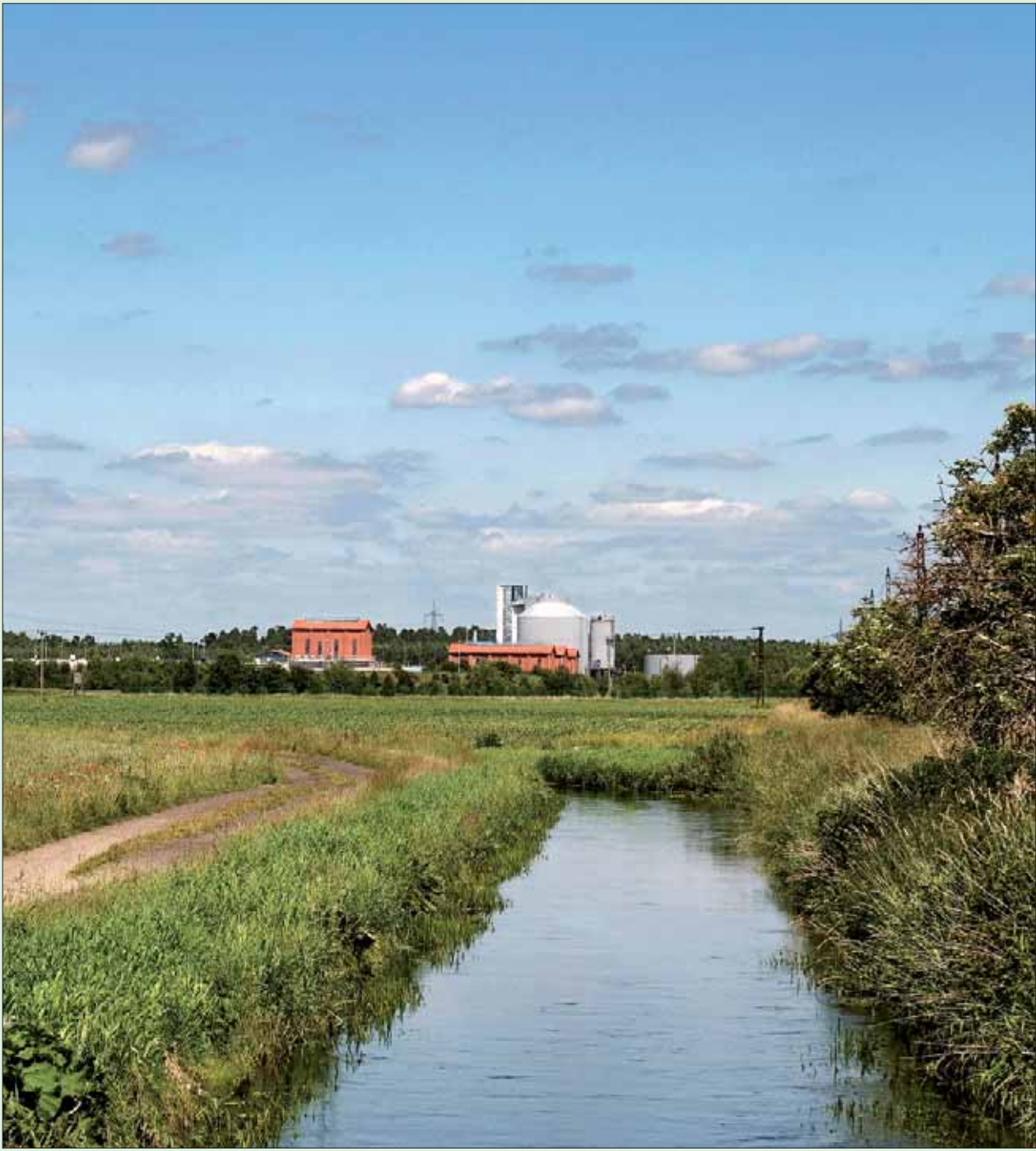
Der offene Ablaufgraben zum Havelkanal
