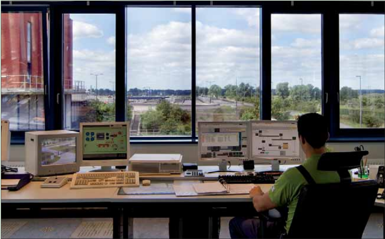
Der Leitstand: Überwachung des automatisierten Betriebs
