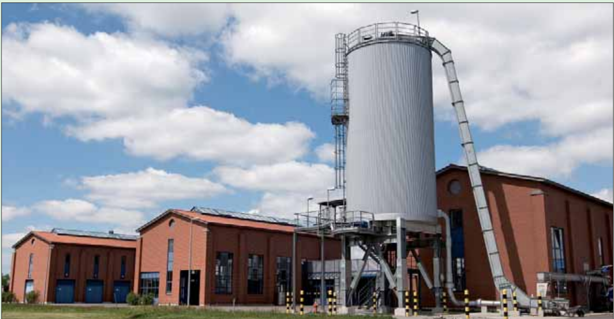
Das Hauptschalthaus, die Gebläsehalle, die Schlammbehandlung (von links)
